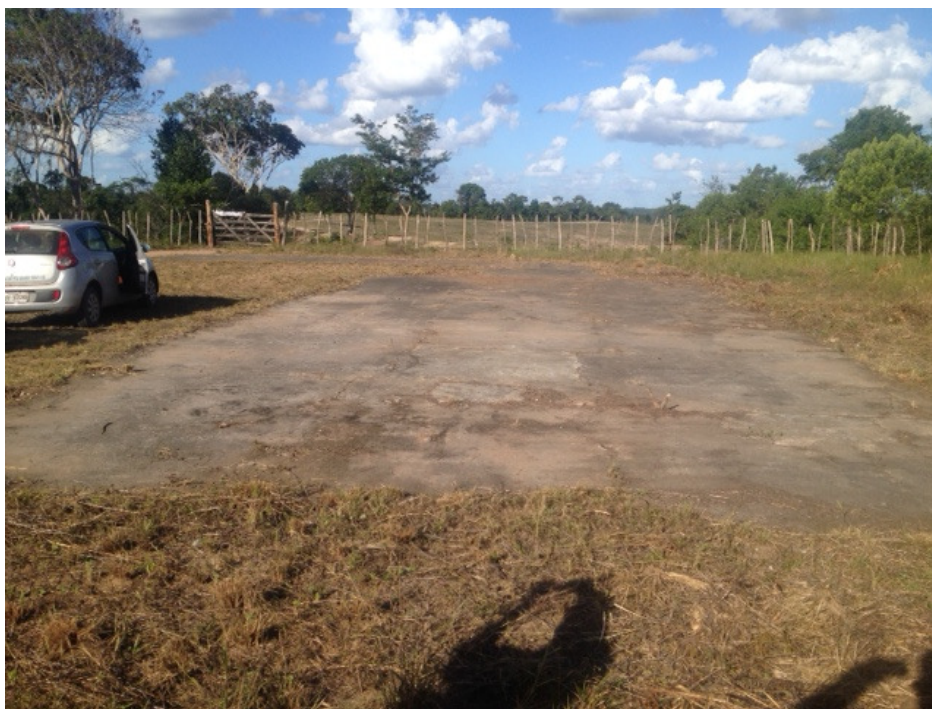
Figura 01: Área do Poço 1-JM-001-BA
